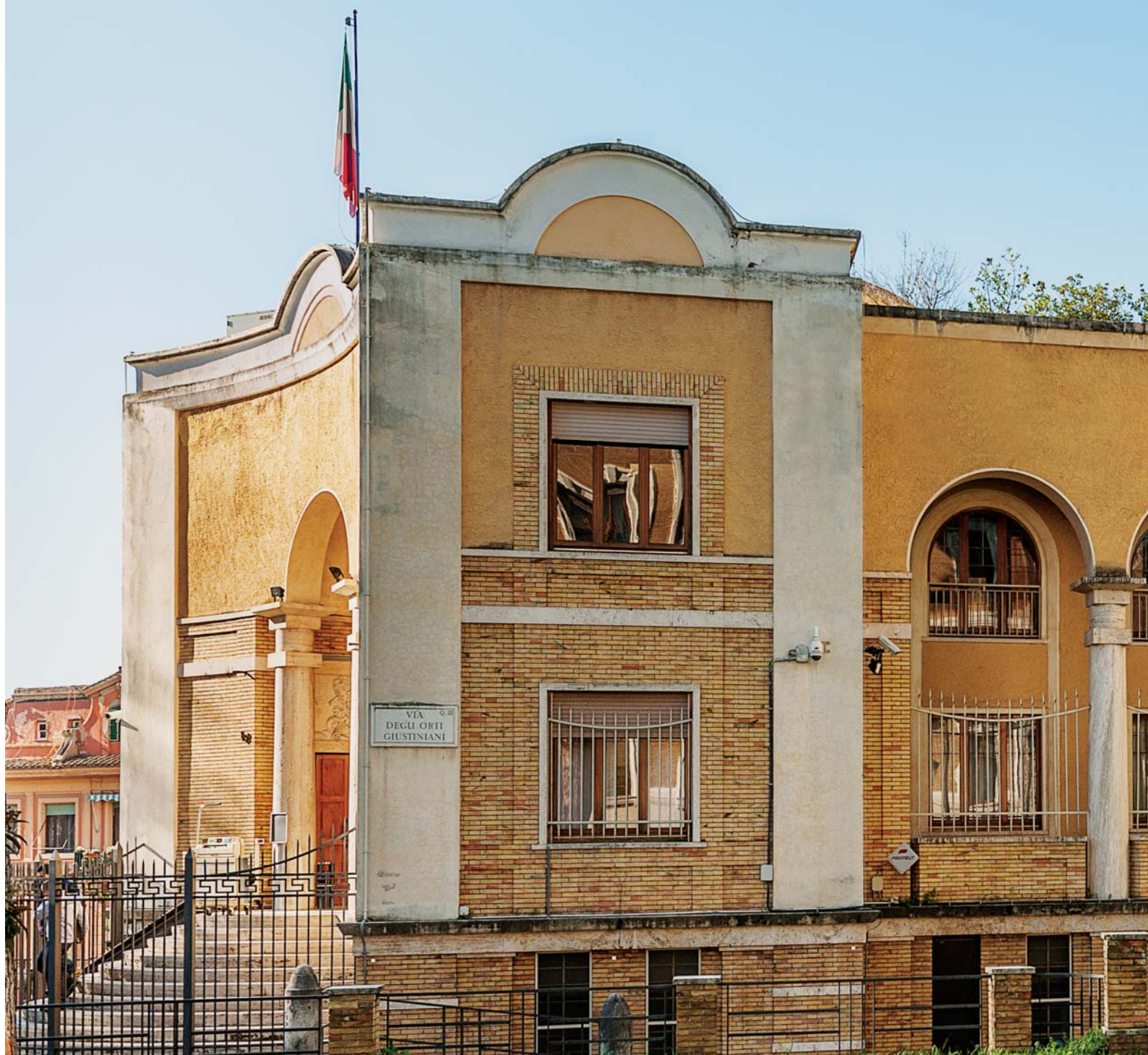
Veduta esterna della Biblioteca (lato nord).
